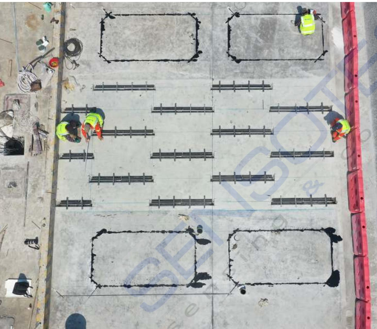
Датчики устанавливаются на ровной поверхности (бетонная плита) в три ряда и чередующейся компоновкой с перекрытием, чтобы свести к минимуму влияние вибрации от грузовиков и неаккуратного вождения на точность взвешивания.
